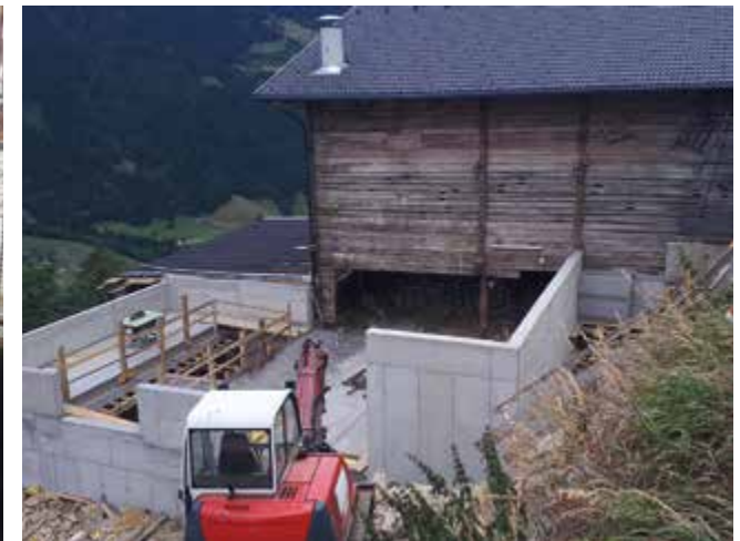
Schwieriger Unterbau für den neuen Laufstall
