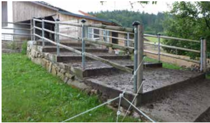
Schrittfreundliche Treppen als Zugang zu Weide
