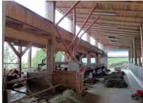
Firstentlüftung bei Zubau
