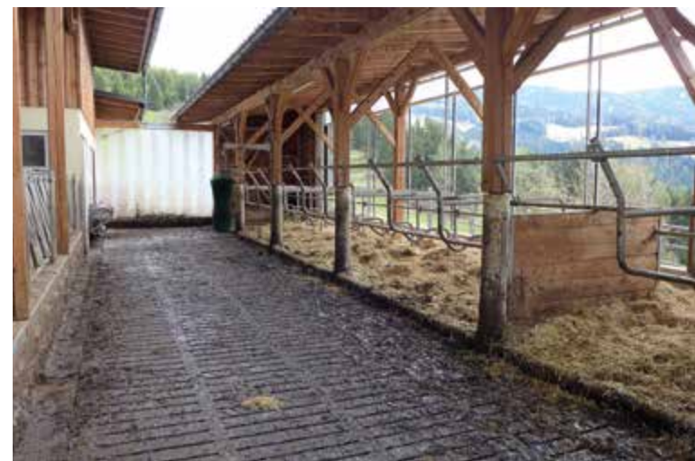
Laufgang mit darunter liegender Güllegrube
