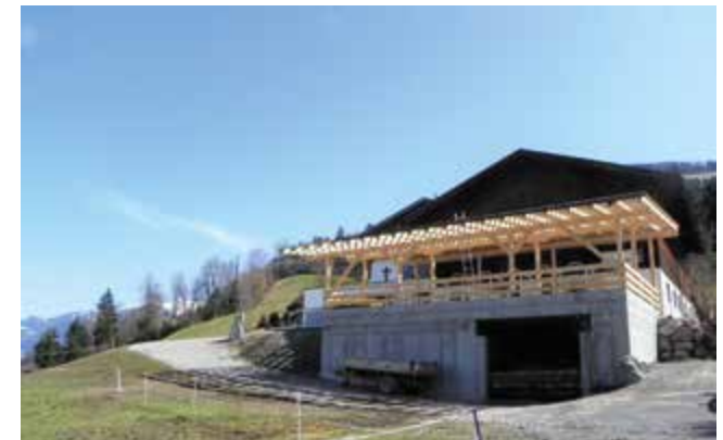
Der Rohbau lässt das fertige Gebäude schon erahnen.
